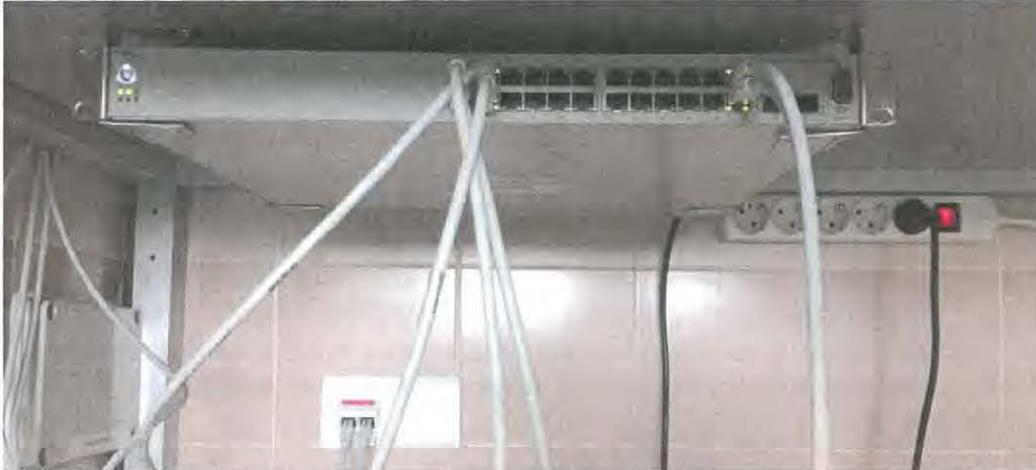
*Figura 5. Switch Nortel Baystack 5510-24T situado bajo balda en estructura de laboratorios remotos.*
